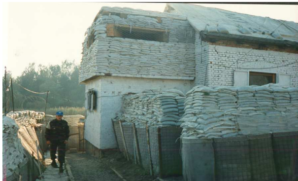
Fot. 81. Wykorzystanie worków do ochrony budynku.
