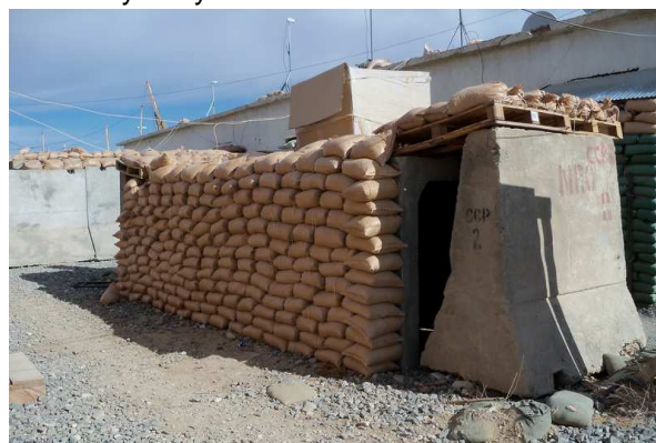
Fot. 83. Wykorzystanie worków do ochrony schronów żelbetowych.
