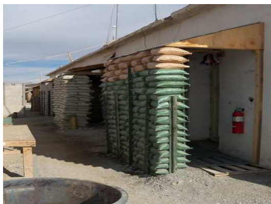
Fot. 82. Wykorzystanie worków do ochrony wejść do budynków.
